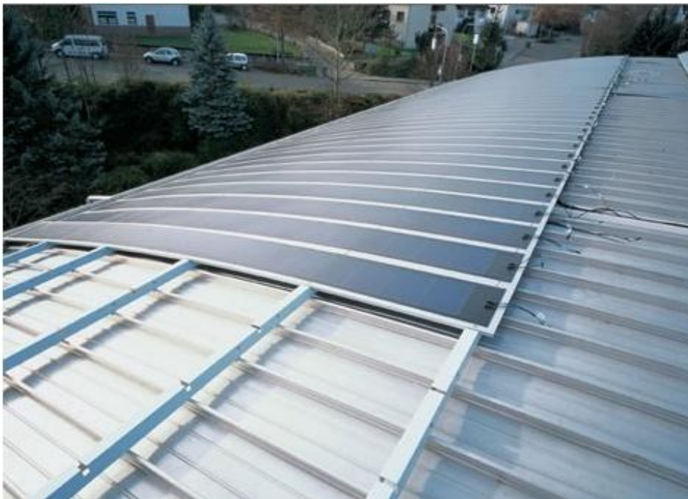
Figura 4.37: Laminado flexible de silicio amorfo pegado sobre paneles machihembrados de aluminio. Fuente: Fotografía realizada por el autor.
