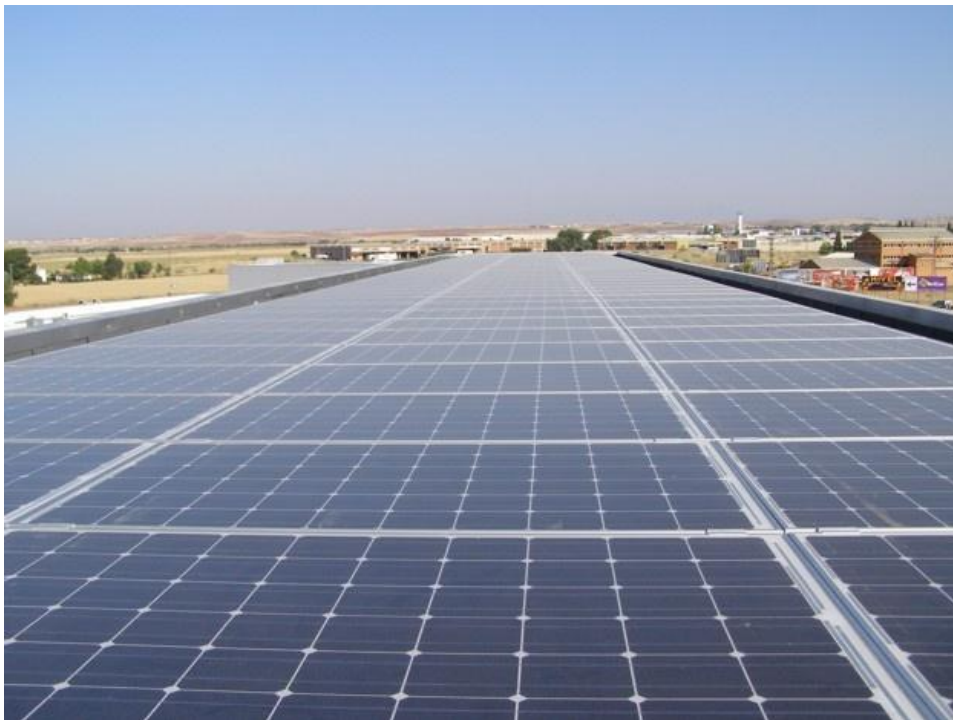
Figura 4.38: Montaje de placas fotovoltaicas en cubierta industrial; Murcia
