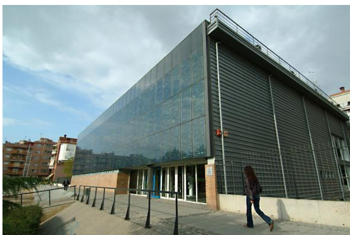
Figura 4.4: Fachada con equalización de presiones con módulos fotovoltaicos como acabado; Edificio situado en Barcelona Fuente: Fotografía realizada por el autor.
