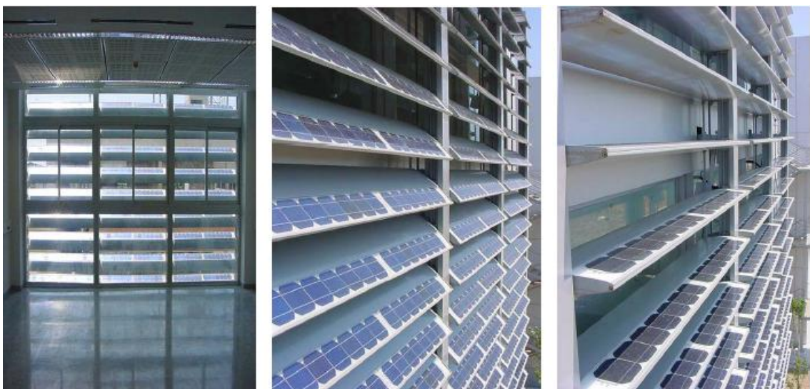
Figura 4.33: Aulario Universitario dentro del campus Tecnológico; Castelldefels Barcelona.
