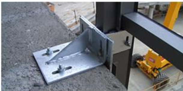
Figura 4.27: imagen de un anclaje de muro cortina modular: se aprecian la placa de anclaje y los ganchos fijados a los módulos. Fuente: fotografía realizada por el autor.
