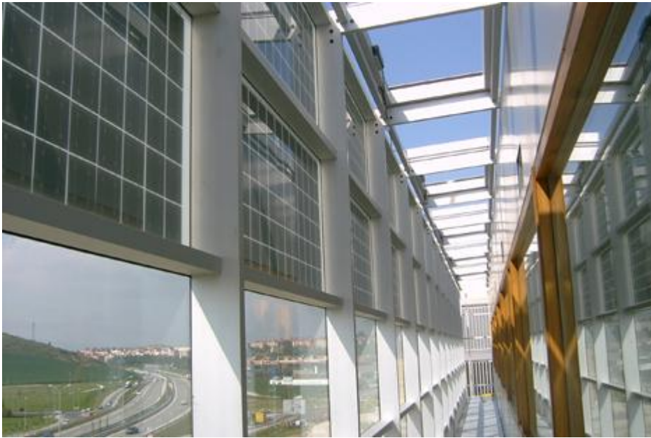
Figura 4.18: Interior del muro cortina del edificio Acciona Solar.
