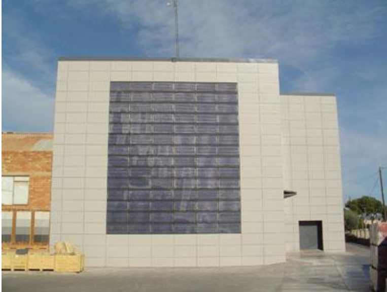
Figura 4.7: Edificio de Atersa y Tau cerámica. Fuente: cedida por Tau Cerámica.
