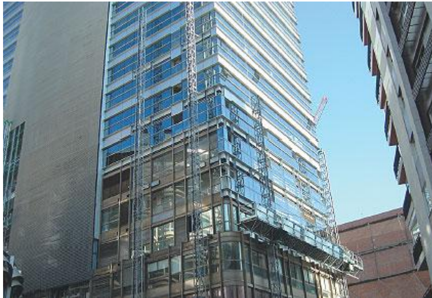
Figura 4.14: Colocación de muro cortina en edificio.
