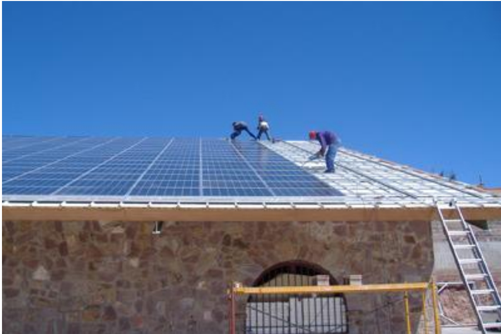
Figuras 3.1 / 3.2 / 3.3 Montaje de cubierta solar.
