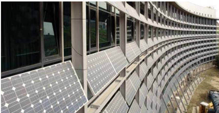
Figura 4.29: Construcción de edificio para investigaciones; Madrid Fuente: Fotografía elaborada por el autor.
